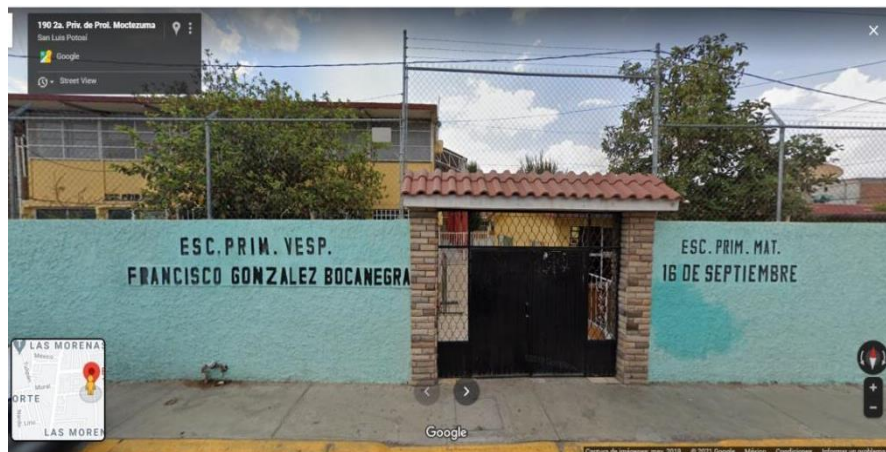
Figura 1. Fachada principal de la Escuela primaria “16 de septiembre”
