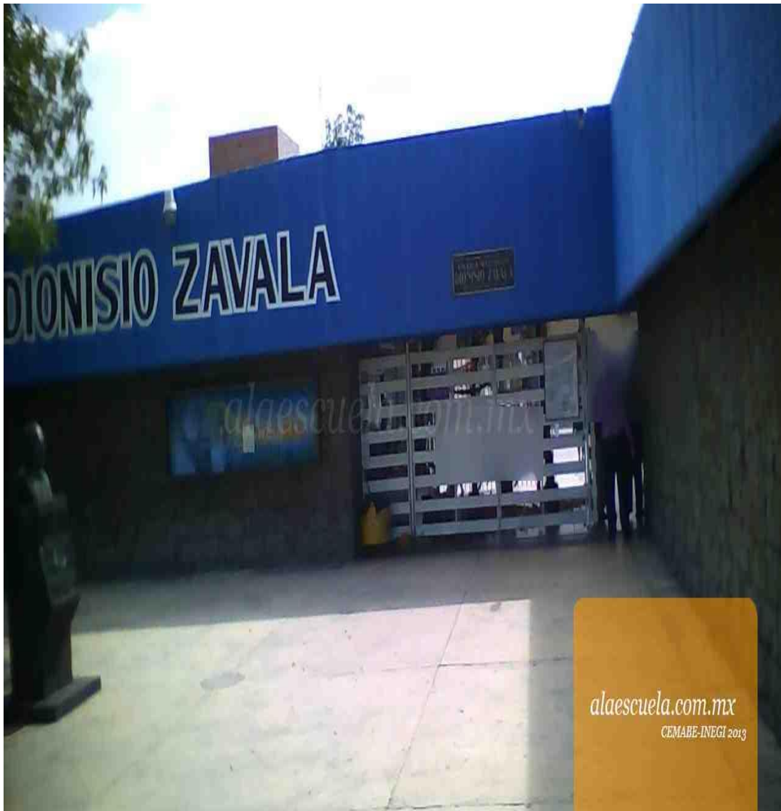
Fachada de la escuela secundaria general "Dionisio Zavala Almendárez"
