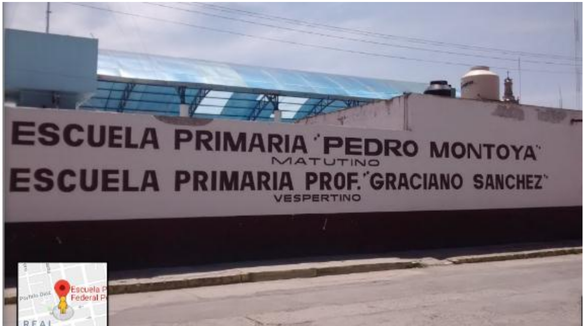
Fachada de la institución.
