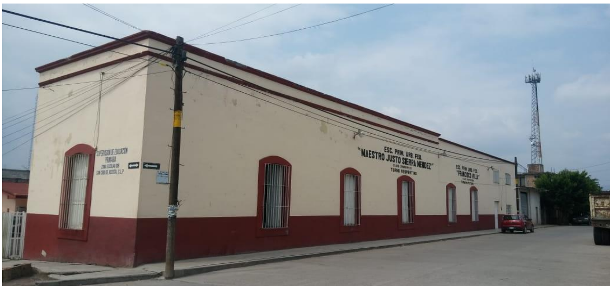
Imagen 3. Fotografía del edificio de la escuela Maestro Justo Sierra. (Viernes 10 de mayo de 2019).
