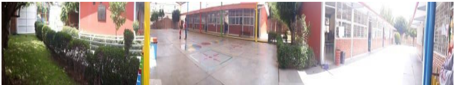
Fotografía panorámica 3: entrada, rampa para discapacitados, patio central y salones alrededor, pasillos y salones.
