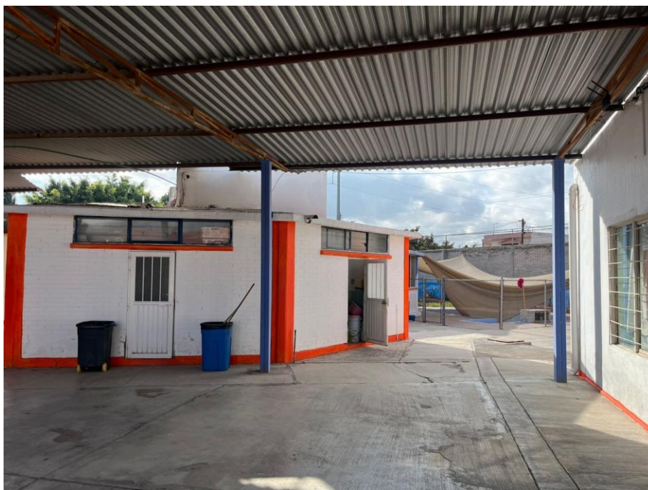
Cocina, salón de intendencia y materiales
