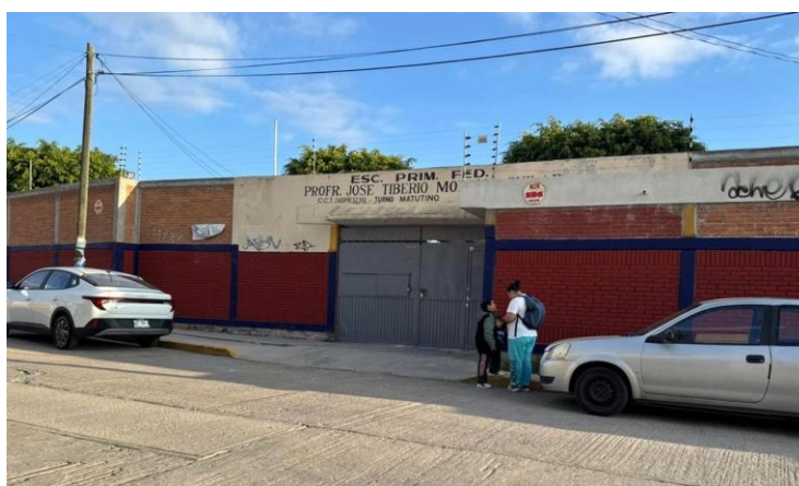
Imagen 1. Fachada de la Escuela Primaria.
