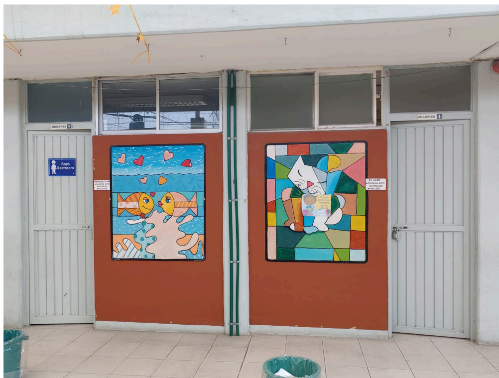
Anexo 6. Baños (exterior)
