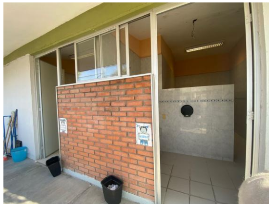
Imagen 8. Área de sanitarios.
