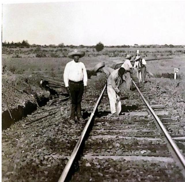
*Ilustración 10 Cuadrilla construyendo y dando mantenimiento a vía. Tomado Enciclopedia tomada Caminos de Hierro, México, STC / FNM, 1996, p. 44*
