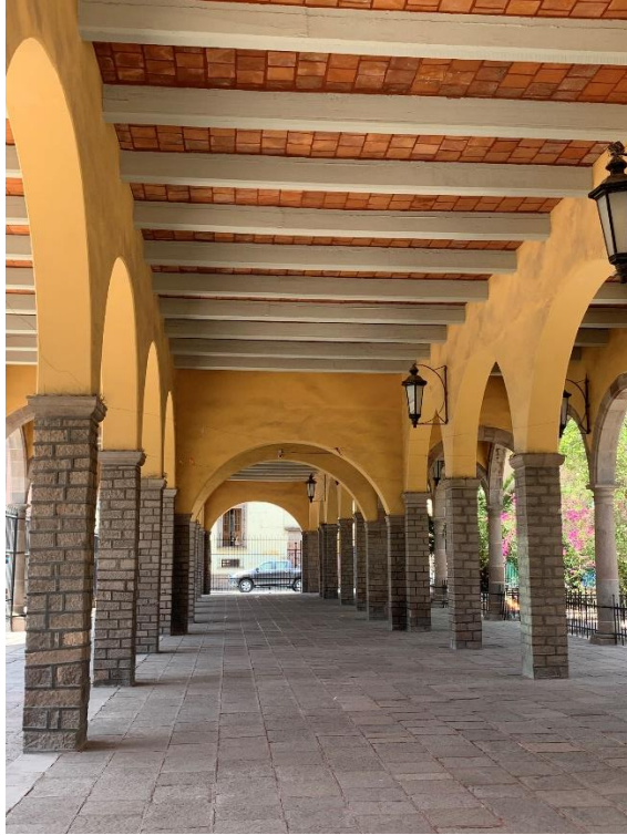
Anexo 7 Arcos en los pórticos oriente, central y poniente
