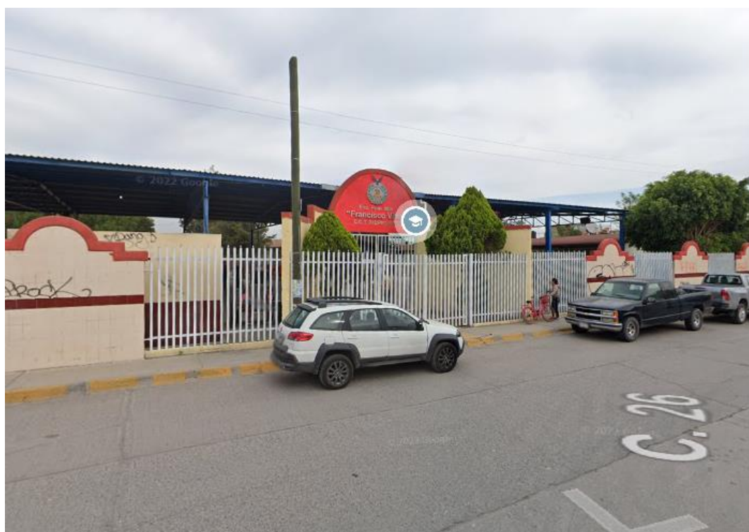
Fuente: Google Maps (03/10/2024). Fachada de la escuela primaria Francisco Villa
