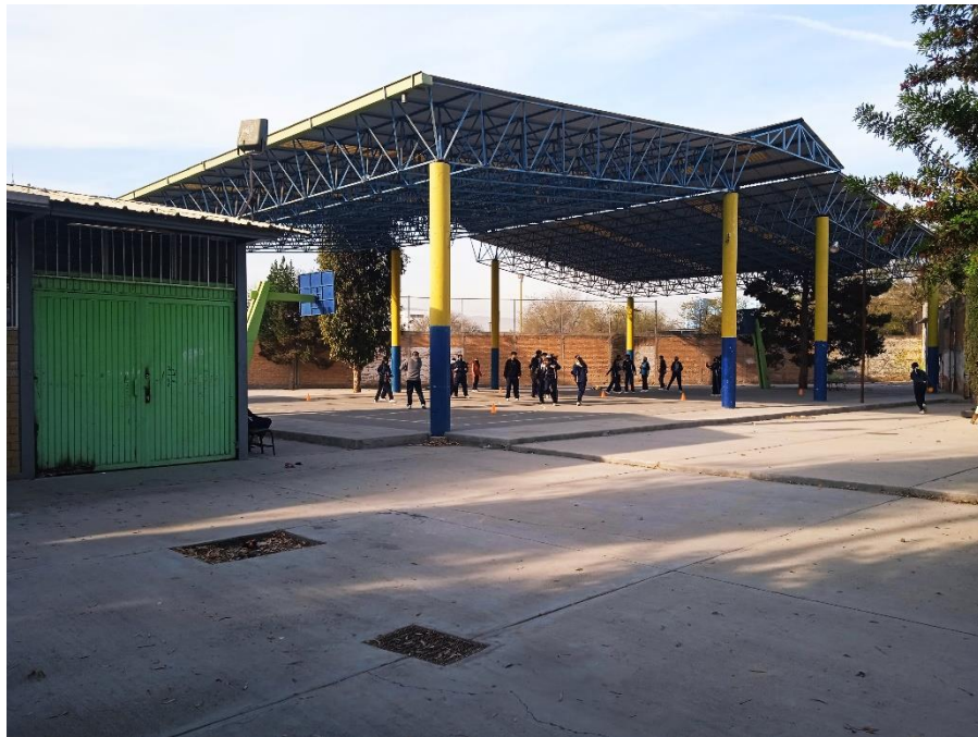
5. Cancha techada en donde se llevan a cabo las clases.
