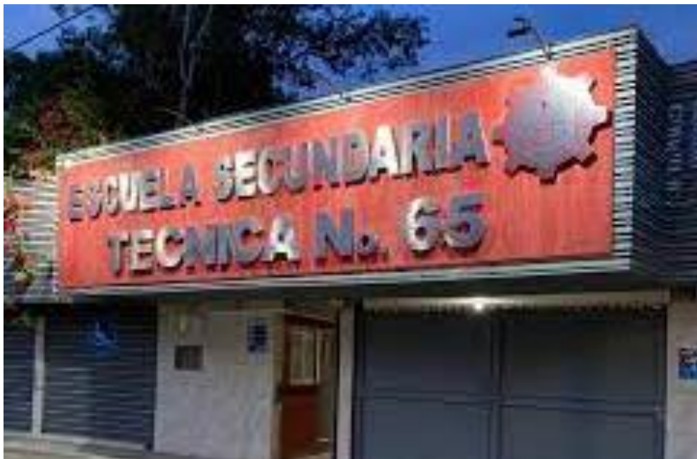
Fachada de la entrada de la institución.
