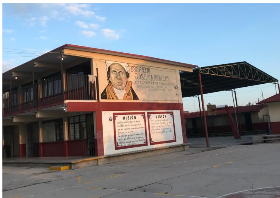
Imagen 3. Edificio principal de la institución . Captura propia el 23 de noviembre del 2022.
