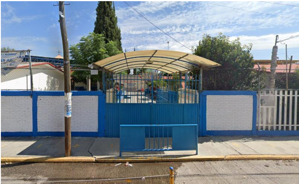
Ilustración 3 Fachada principal de la Escuela Primaria “Niños Héroes”
