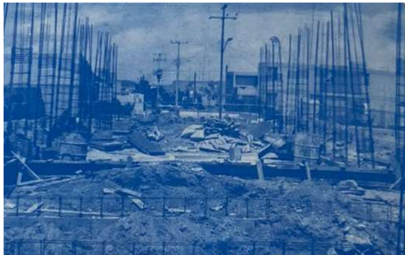
Imagen 2. Se inicia la construcción del edificio CATRA que alberga a los actores educativos durante casi dos ciclos escolares.
