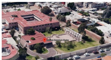
Evidencia fotográfica #5 fotografía satelital del Instituto.
