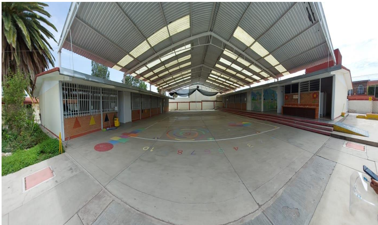
Ilustración 3. Edificios A y B, patio principal y bodega de la bomba de agua.
