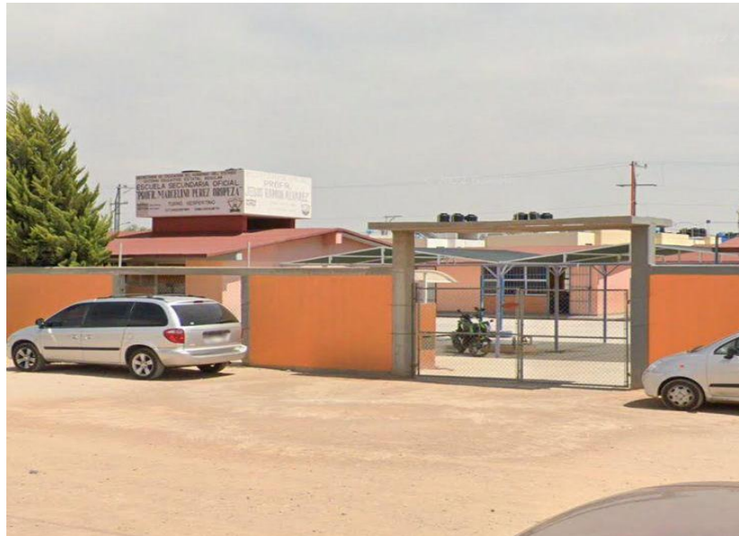
Figura 2. Fachada exterior de la Escuela Primaria Jesús Ramón Álvarez. Fuente: Google Earth.
