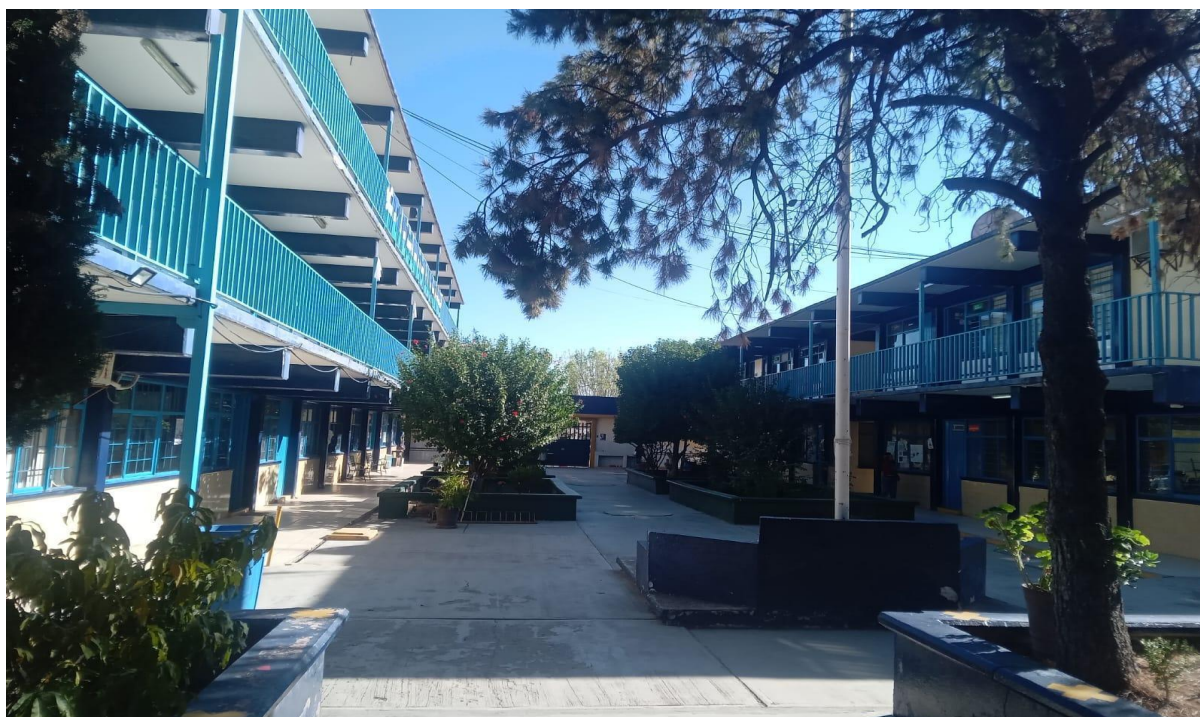
Imagen 15. Pasillo del edificio 1 y 2
