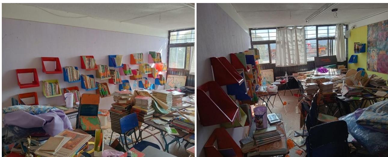
Imagen 2 y 3. Proceso de reforma de la biblioteca escolar
