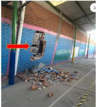
Como se observa en la imagen existe un daño de desprendimiento de muro con un diámetro de 1.15 m de espesor en muro de ladrillo.
