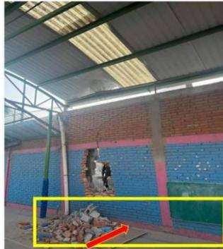
Por el riesgo de colapso del muro no se puede determinar con claridad si existe daño a la cimentación del muro, esto se determinará una vez concluida la demolición del muro y observando de manera segura si es que existe un daño en cimentaciones.
